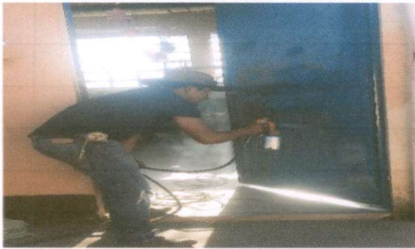
FOTO 3: Sustitución de puerta
