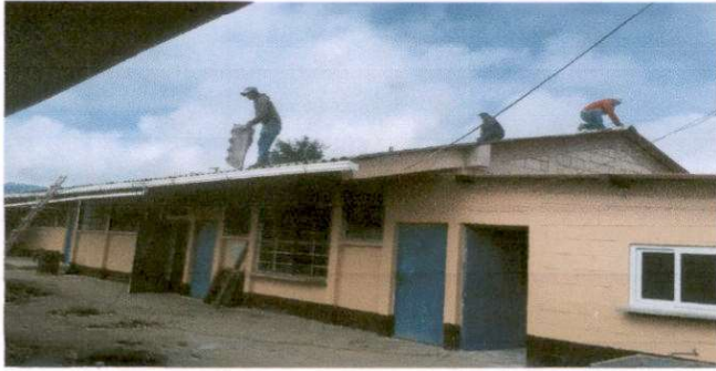
FOTO 1: Sustitución de lamina por lamina troquelada aluzinc
